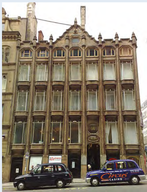
世上第一棟鋼架結構建築，五層高。
